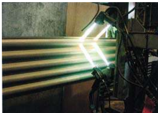
▲ 水壁パネルの溶射施工写真
