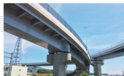
⑧ 高速道路 Tヘッド工法鉄筋加工技術 高周波曲げ加工技術(排水管)
