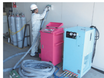
塗膜剥離加熱工事 ・ゴム・塗装の剥離にIH加熱! ・下地の鋼板を誘導加熱し簡単に除去 ・廃棄物発生量を大幅に低減
