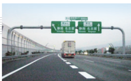
⑦ 高速道路(標識柱)(ETCガントリー) 高周波曲げ加工技術
