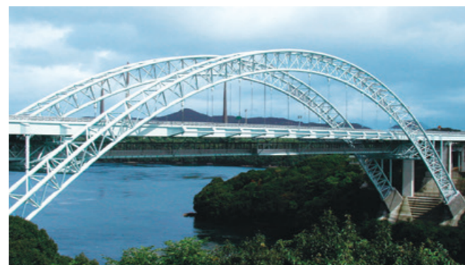
大半径曲げ 大半径曲げ(10DR~∞)は、建屋や構造物に数多く採用されています。
