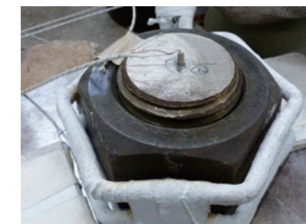
ナット加熱工事 錆やかじり、焼付により固着したナットを加熱することにより簡単に緩めることができます。
