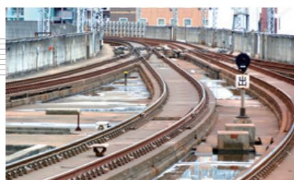
⑥ 鉄道(レール) 高周波焼入技術
