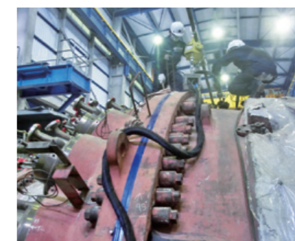
高周波ボルトヒータ工事 タービンなど大型ボルト、締め付け開放時の加熱作業を現地に対応(工程大幅短縮に有効)。
