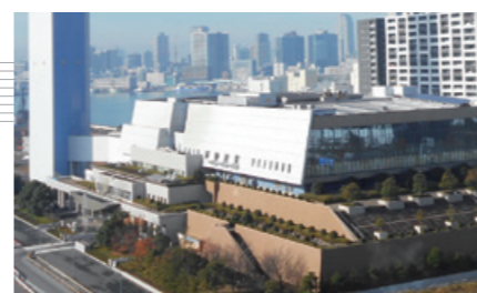
③ 清掃工場 DHFバイメット®技術 ボイラーチューブ弛緩技術
