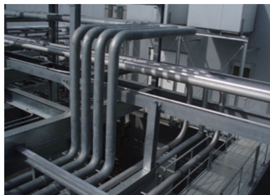
平面曲げ・立体曲げ 石油化学プラント等に採用されており、溶接箇所の低減に貢献いたします。
