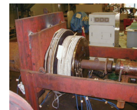
焼き抜き用加熱工事 カップリング・ギヤー・シャフトなどの焼き抜きに有効。作業改善・工期短縮ができます。もちろん焼きぬきもOK!
