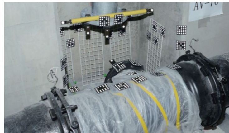
現地調整管計測
