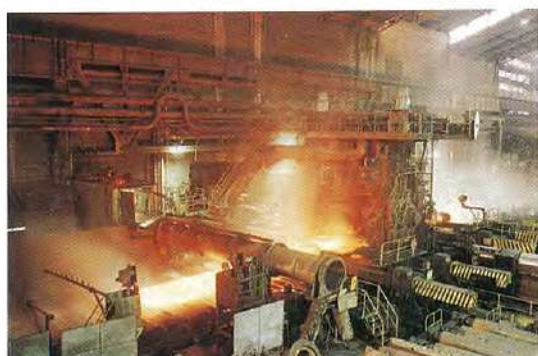
厚板仕上設備 Plate Mill
