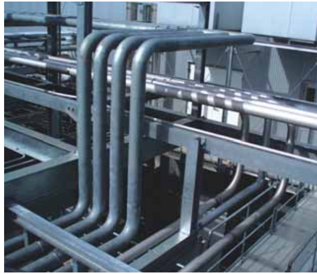
石油化学プラント
