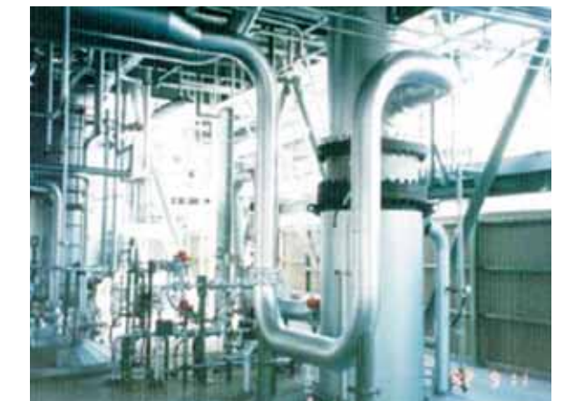
ウェルドレス工法を採用したプラント配管
