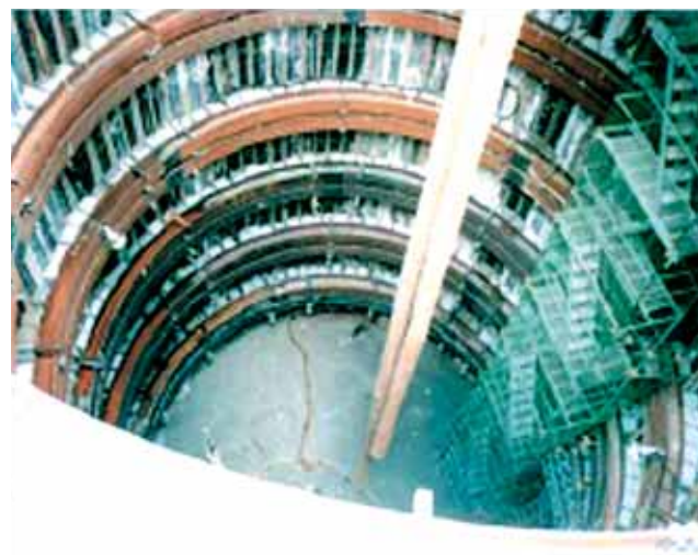
ガイドリング 現地埋め込み風景
