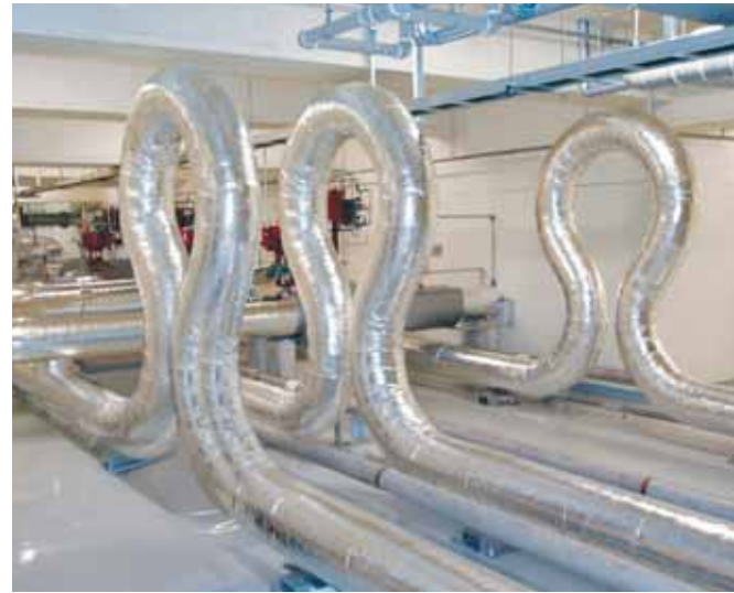
実プラント施工写真
